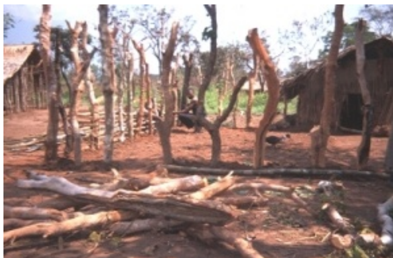
Photo 4 - Construction de l'élevage de Gbakassa
