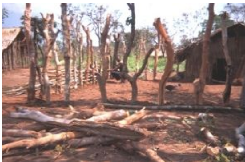
Foto 4 - Costruzione allevamento di Gbakassa
