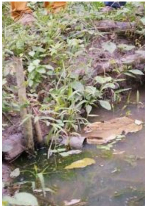
Foto 12 e 13 - tubo per il collegamento tra due vasche e chiusa tra canale di adduzione e vasca
